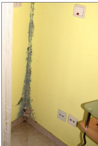
verschiedene Schimmelpilzschäden
