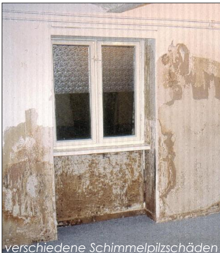
verschiedene Schimmelpilzschäden
